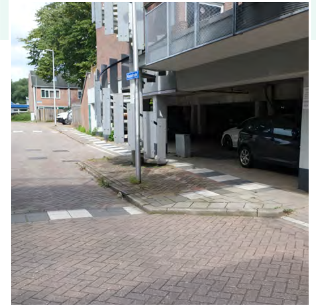
parkeren onder het dek maakt de begane grond onaantrekkelijk
